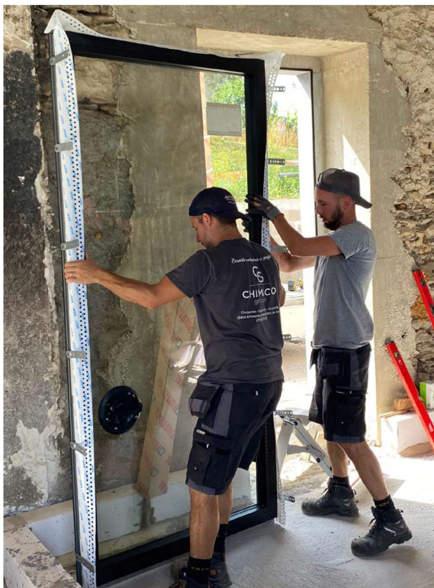
Les protections solaires et la pose de châssis font désormais partie des domaines d'expertise de CHIMSCO
